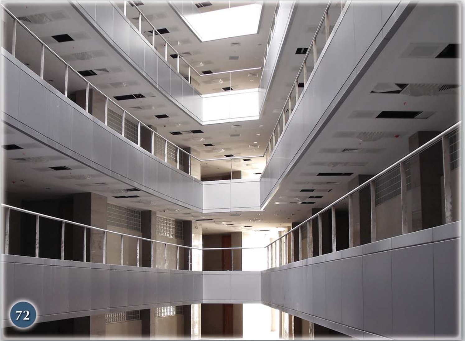
Çağlayan Adliye Sarayı Kompozit Uygulama
