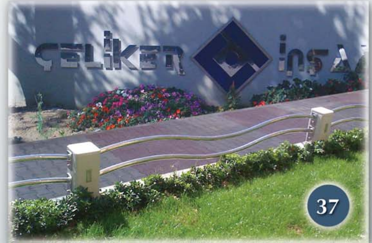
Duvar Üstü Korkuluk ve Paslanmaz Harfler
