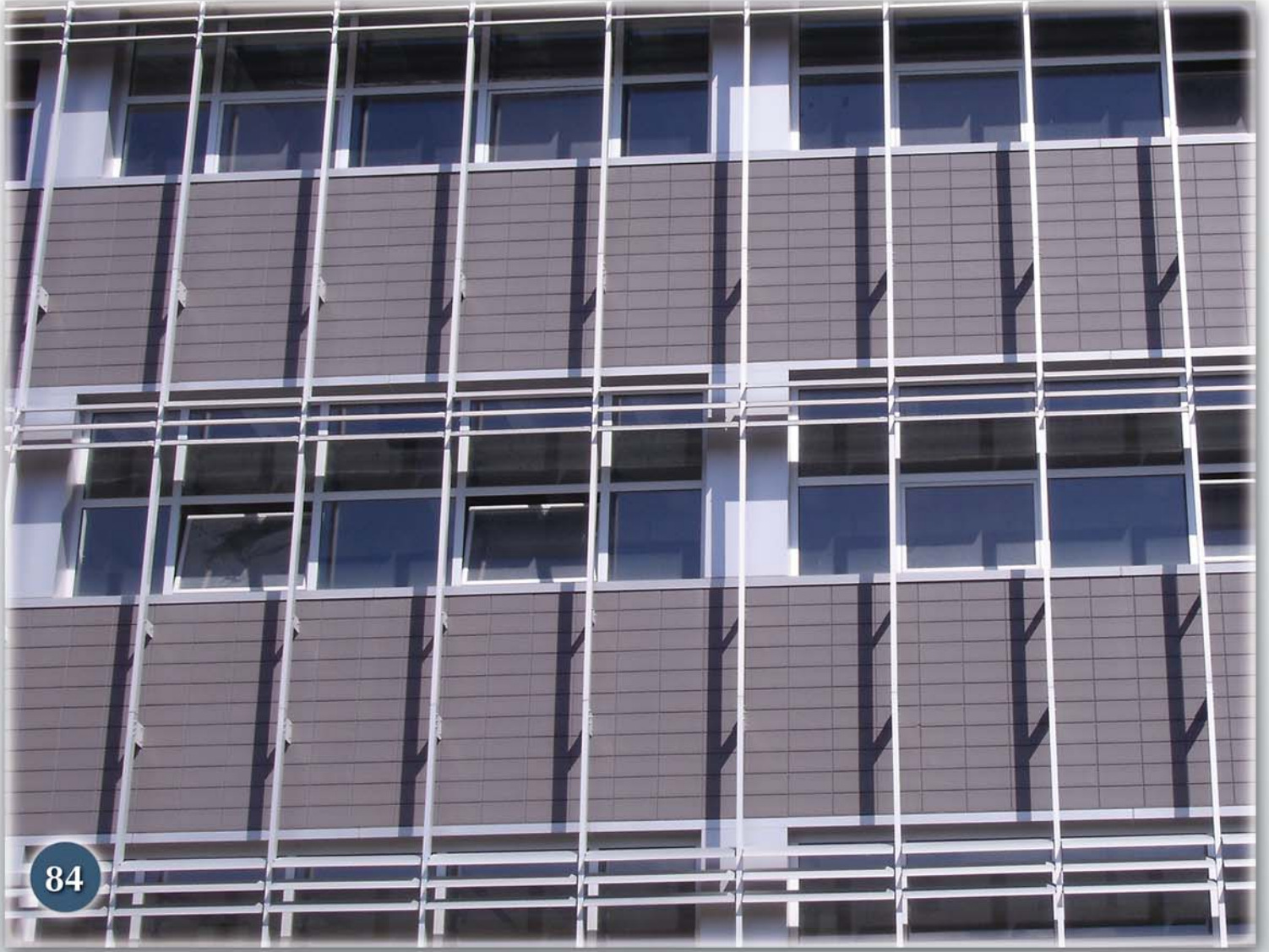
İTÜ Rektörlük Binası Aluminyum Güneş Kırıcılar
