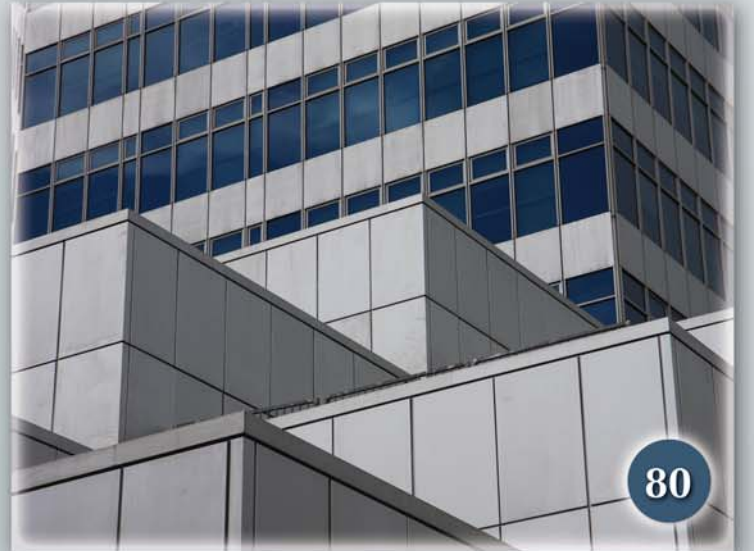
Kompozit Panel Doğrama
