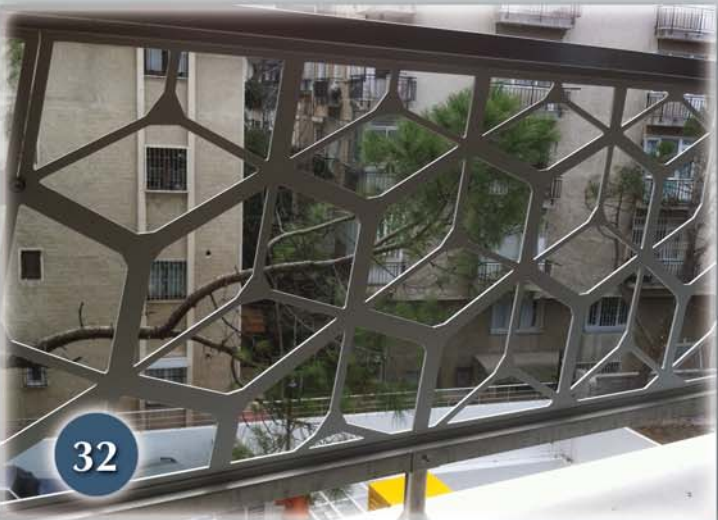
Aluminyum Saçtan Balkon Korkuluk
